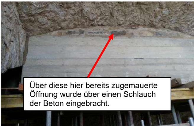
Über diese hier bereits zugemauerte Öffnung wurde über einen Schlauch der Beton eingebracht.
